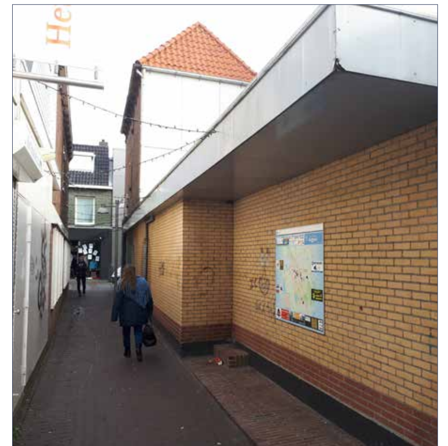
Halverwege de steeg een verspringing in de zuidelijke gevel.
