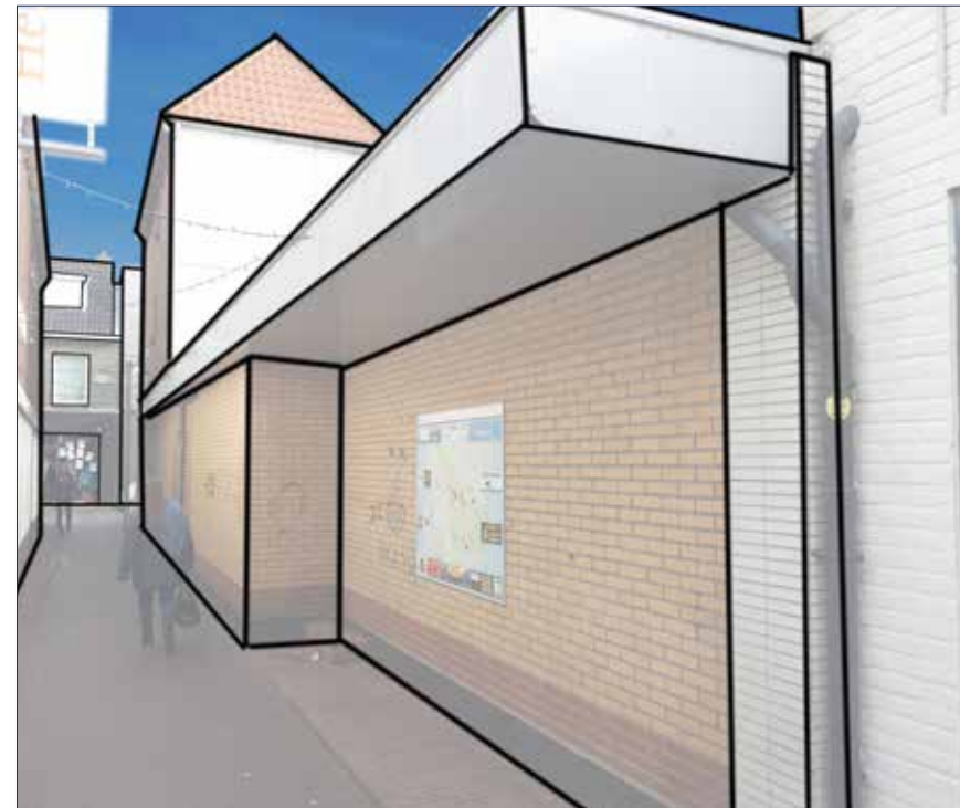
Het 'hoekje' dat ontstaat bij de verspringing in de gevel wordt als onprettig ervaren door gebruikers van de steeg.
