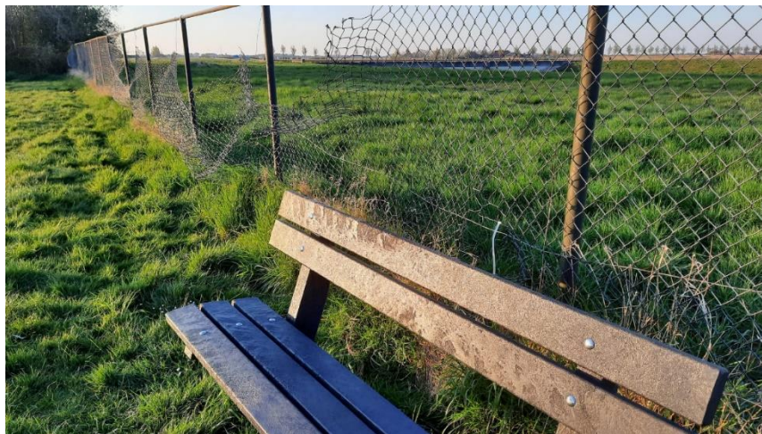
Figuur 1.4.1 Hekwerk bij ligplaatsen aan It Stalt te Akkrum
