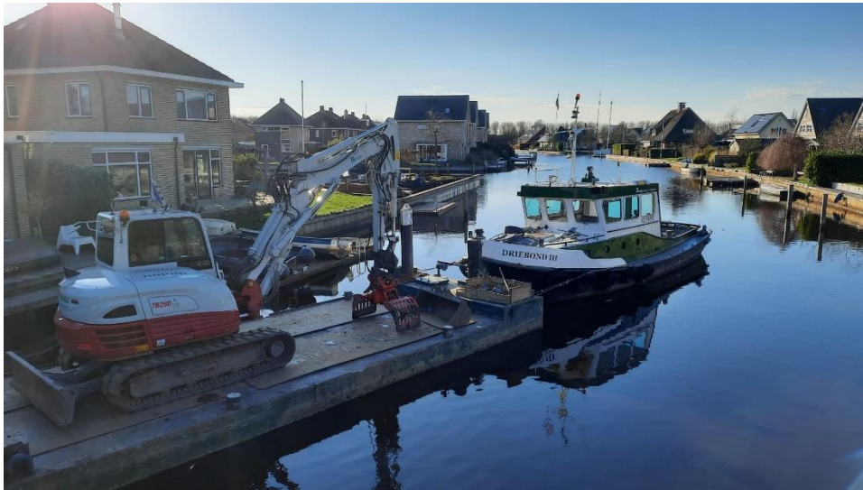
Figuur 2.1.2 Vervanging van damwanden in Akkrum
