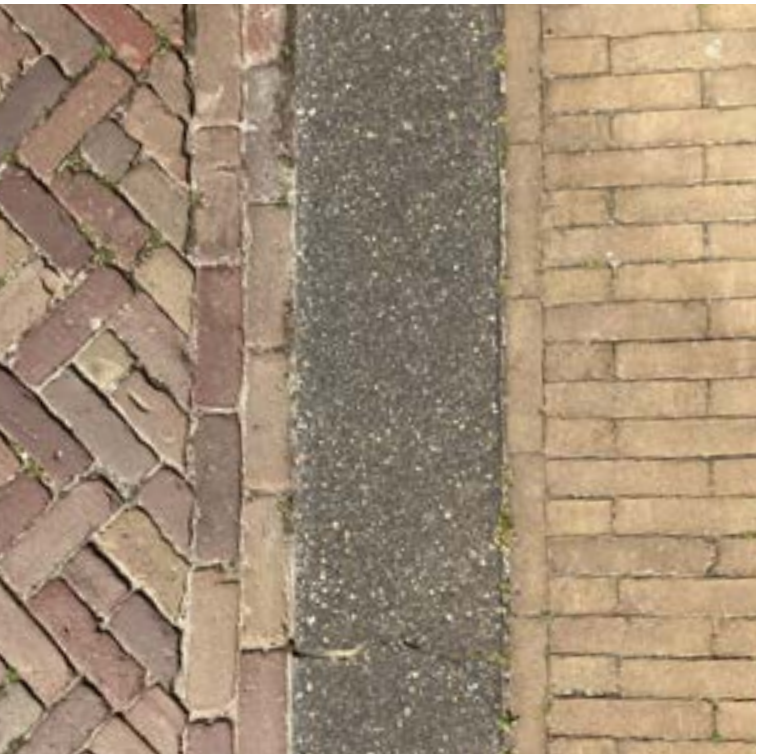
Huidige bestrating rijbaan-trottoirband-trottoir in Andringastrjitte.
