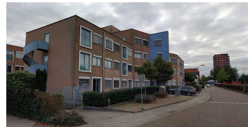
Transformatie kantoor naar wonen – Stationsweg, Heerenveen 2
